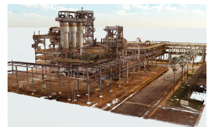
Serviço de Inspeção por Laser Scanning
